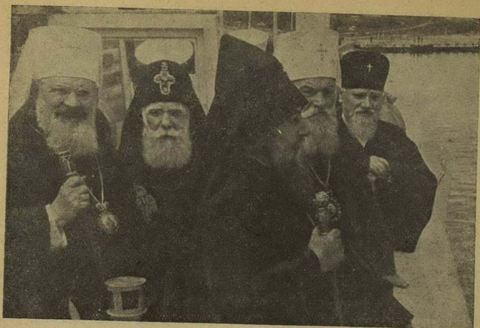
На канале им. Москвы
