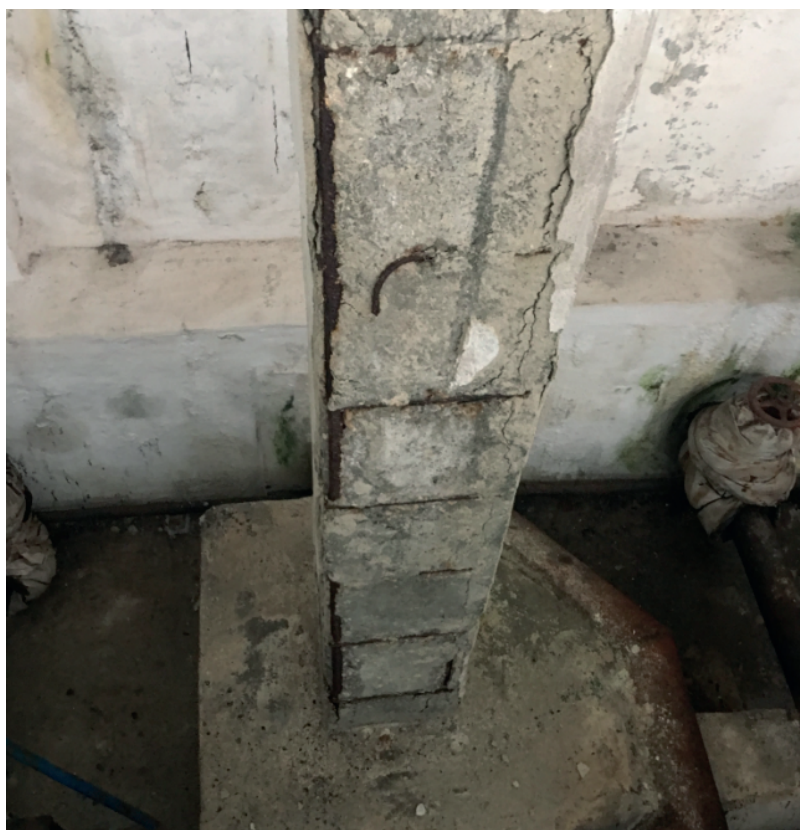
Рисунок А.1.2.4 - Железобетонные колонны с поврежденным защитным слоем железобетона и участками оголенной арматуры
