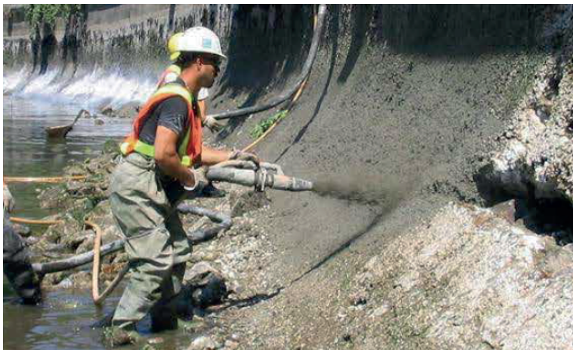
Рисунок В.2 – Мокрое торкретирование
