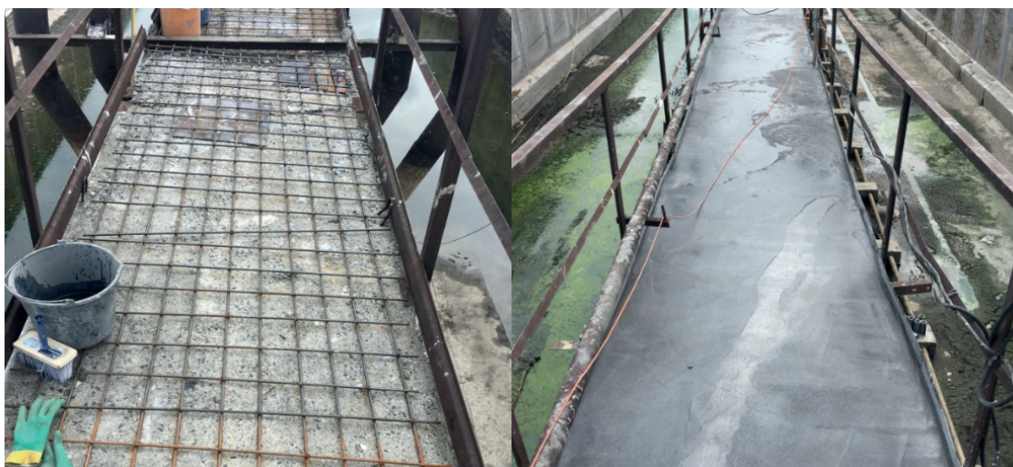
Рисунок А.1.4.3 – Ремонт плит проходных мостиков.
