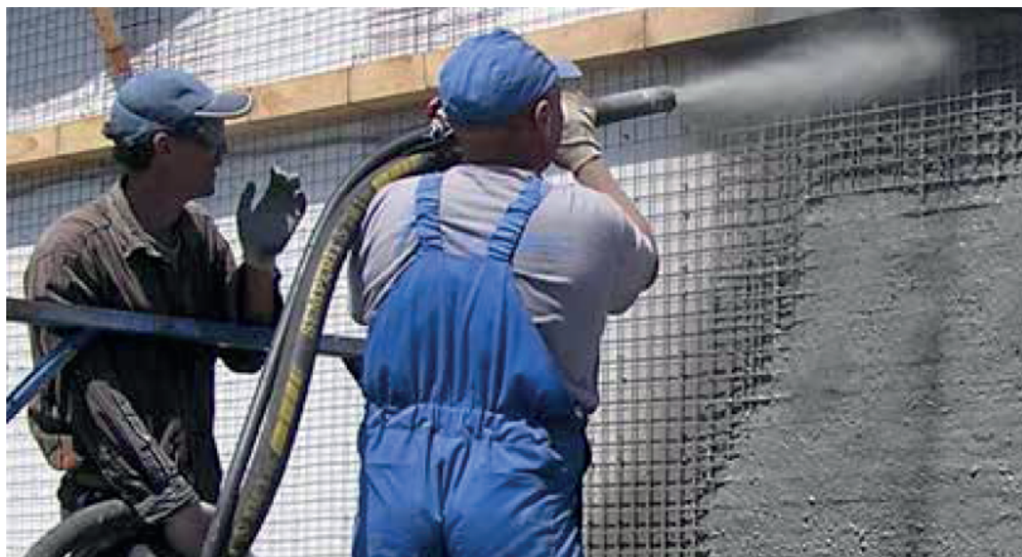
Рисунок В.1 – Сухое торкретирование
