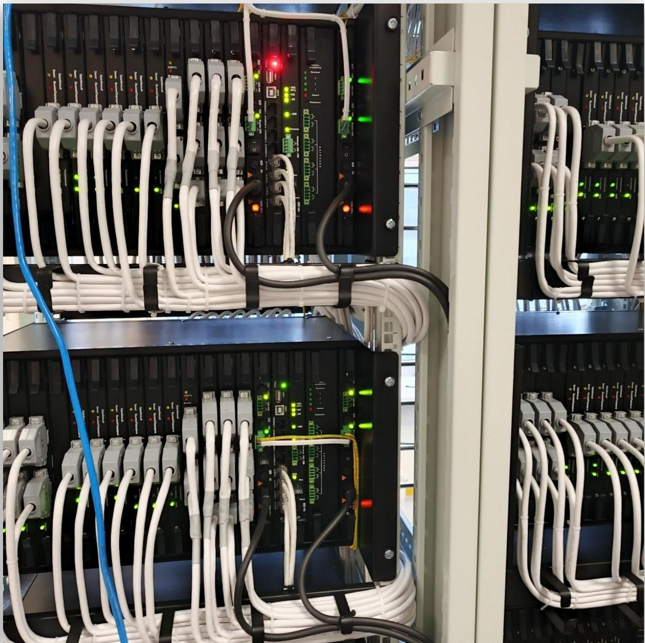
На фото ниже показан еще один пример 100% резервированная система связи со 100% резервированной схемой электропитания от 2-х разных ЛЭП и АКБ-1.
