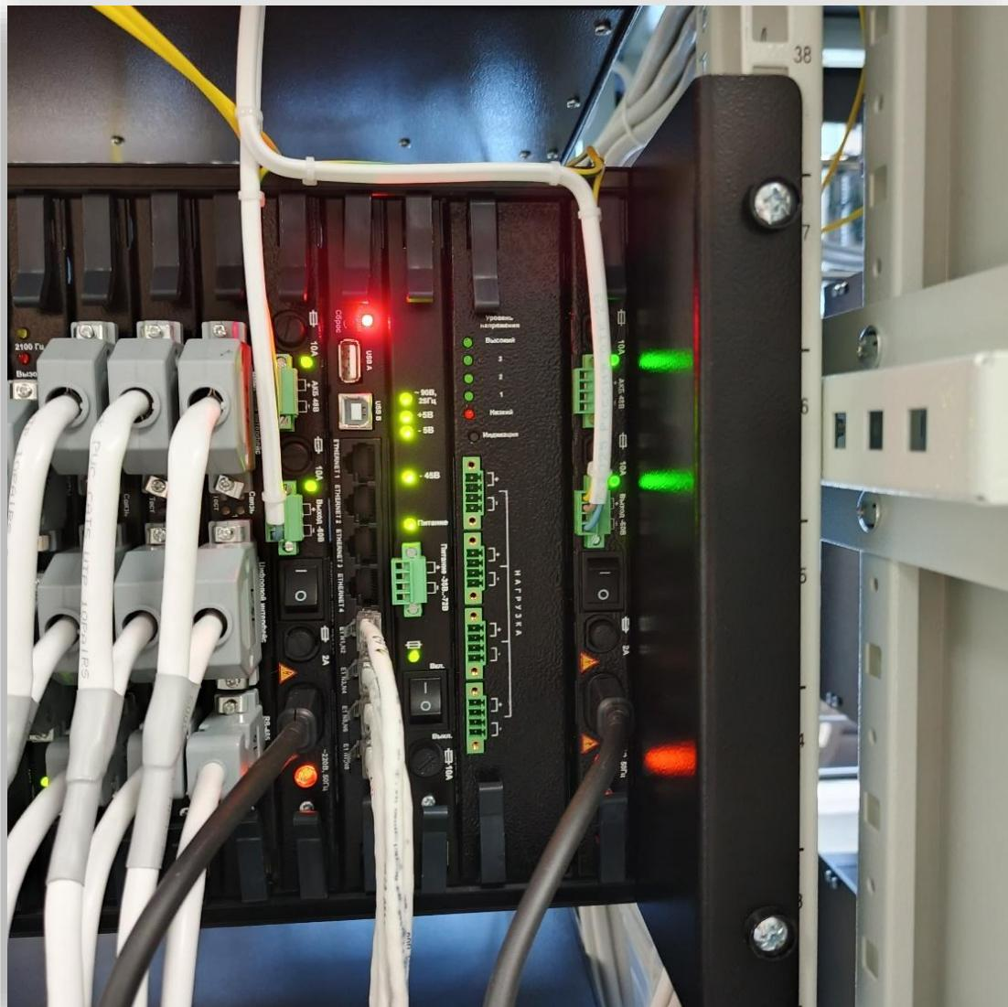
На фото ниже показана 100% резервированная система связи со 100% резервированной схемой электропитания от 2-х разных ЛЭП и АКБ-2.
